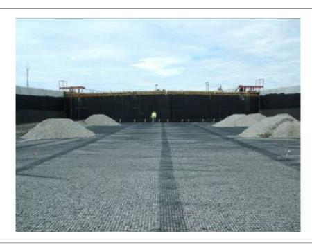
Замена железобетонного свайного ростверка двухосными георешетками Тенсар
